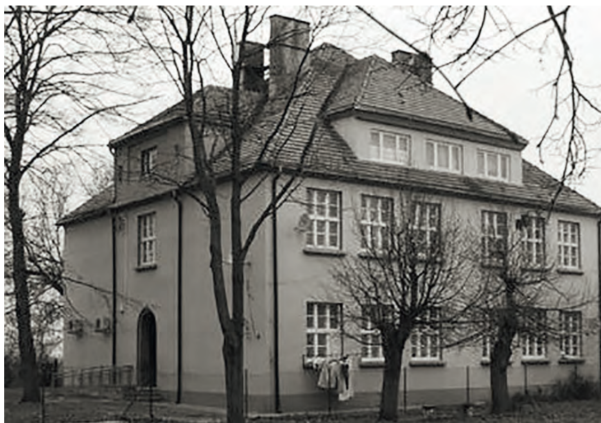
Budynek szkoły w Górkach.
