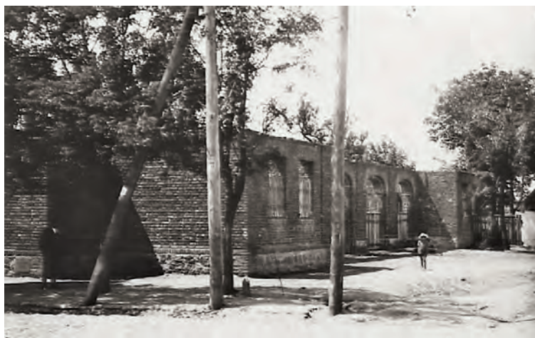
Dawna remiza strażacka w Kłodzku usytuowana przy skrzyżowaniu ulic: Poznańskiej i Dąbskiej.
